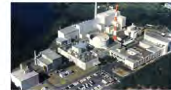
常陽: 高速実験炉
